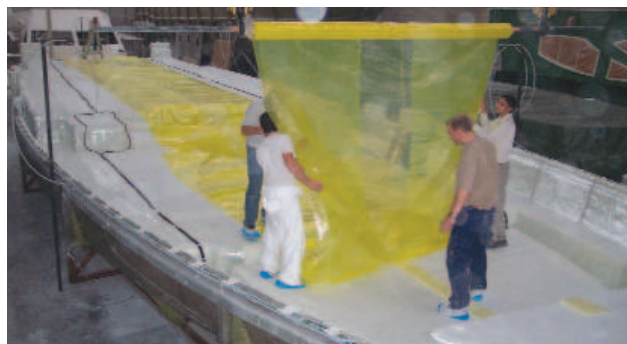
Dopo aver deposto tutte le fibre all'interno dello stampo, sulla superficie vengono messe in opera specifiche canaline che serviranno per far circolare la resina sottovuoto. Una volta realizzato il circuito di aspirazione dell'aria, il tutto viene sigillato da un apposito controstampo flessibile (il sacco giallo in figura).
