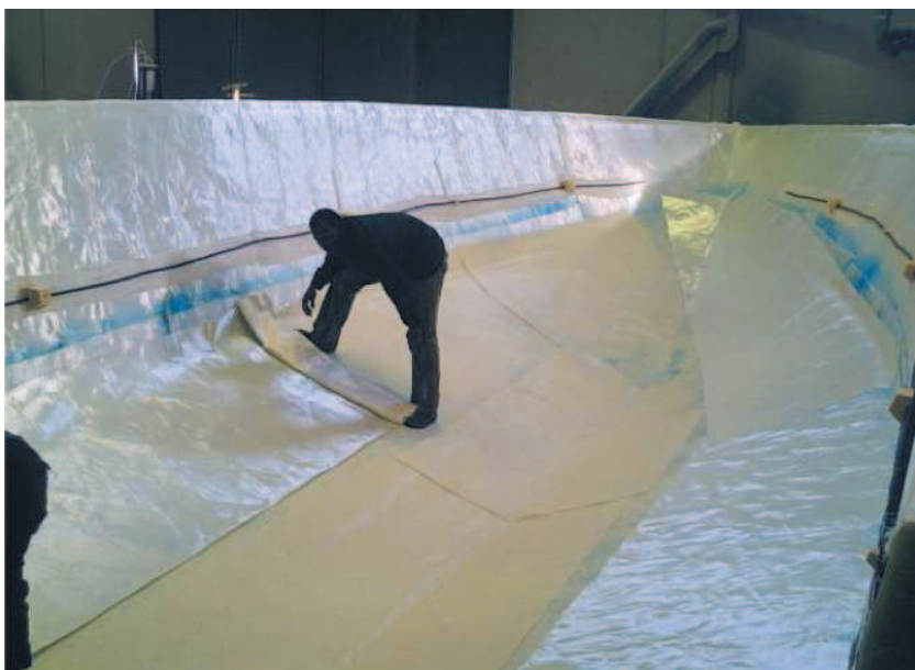
Fig. 2: Dopo lo skincoat, gli operatori hanno provveduto a posare in opera i rinforzi vetrosi 'asciutti'.
