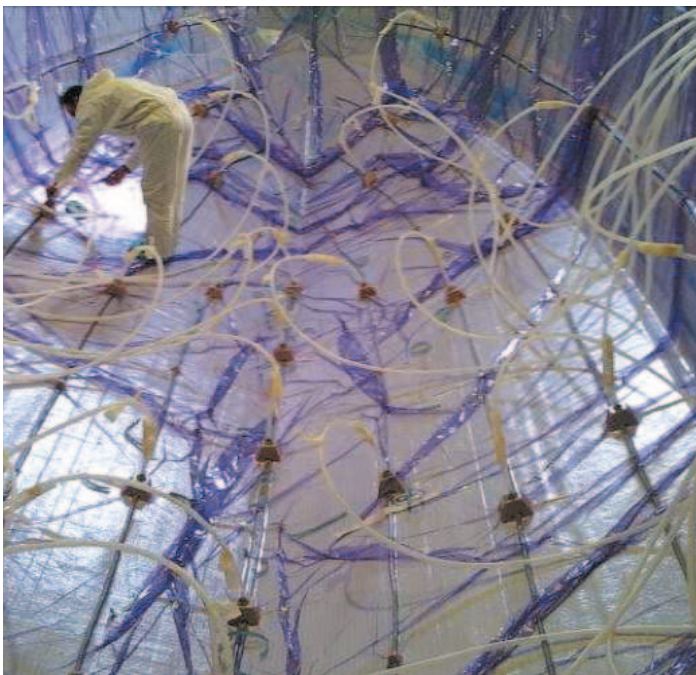
Fig. 3: Nella terza e quarta fase, sono state installate le linee, le portate, ed il sacco per il vuoto
