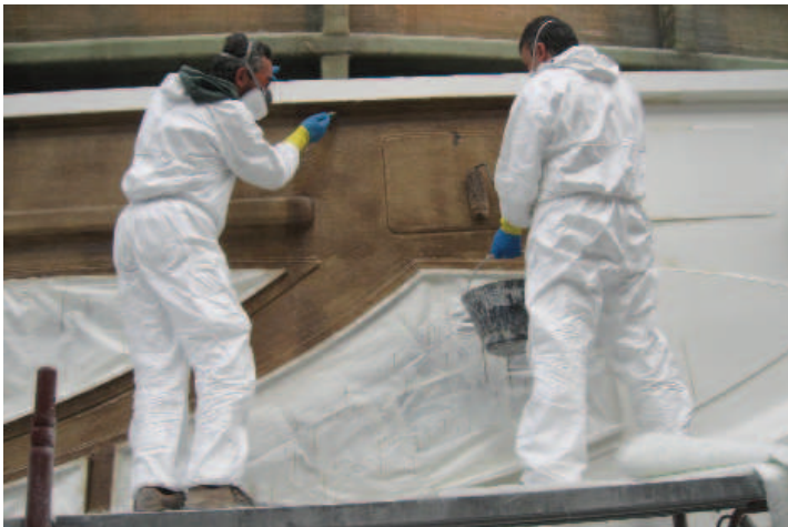
Laminatori durante la fase di impregnazione con resina, della fibra di vetro adagiata nello stampo sul fianco di una sovrastruttura fly.
